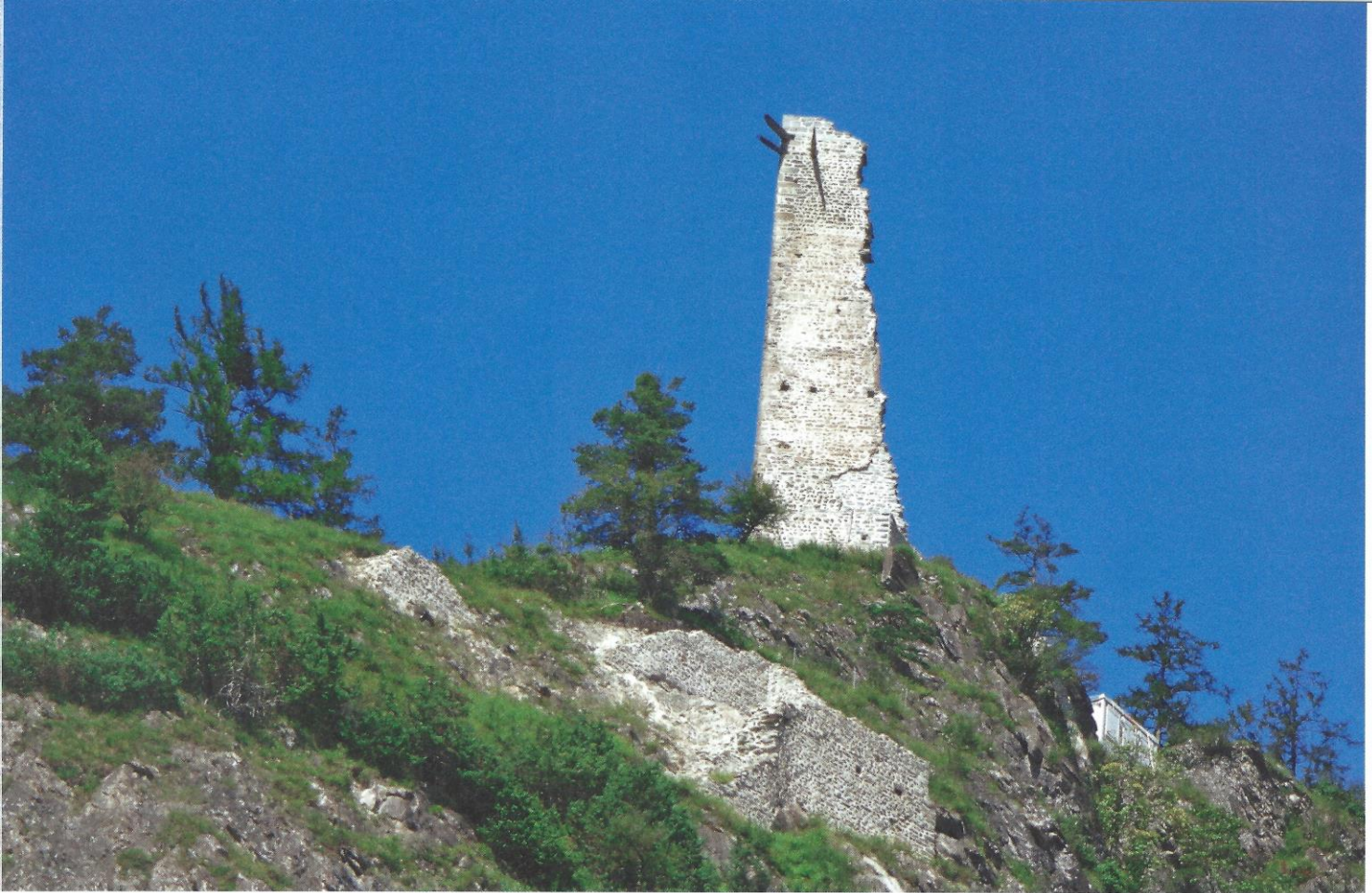
↑ Burgruine Juvalt von 1216: Gesicherter Turmzahn mit wieder eingesetzten Kragbalken (Foto Felix N.)
